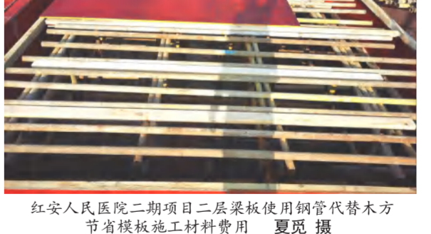
红安人民医院二期项目二层梁板使用钢管代替木方节省模板施工材料费用 夏觅 摄
