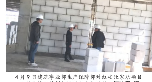
4月9日建筑事业部生产保障部对红安泛家居项目1#综合楼砌体样板墙进行内部验收 何玲霞 摄
