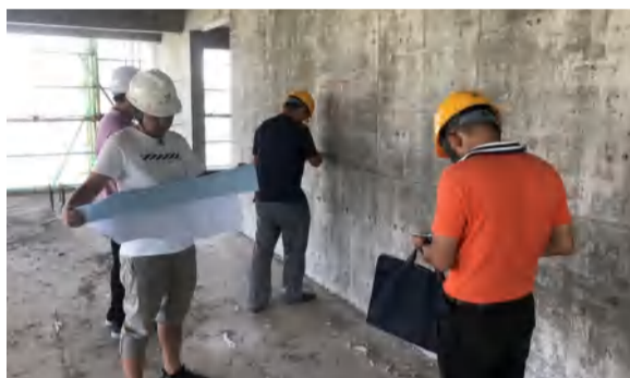
质监站对东方明珠项目 3#5# 楼进行主体结构验收
