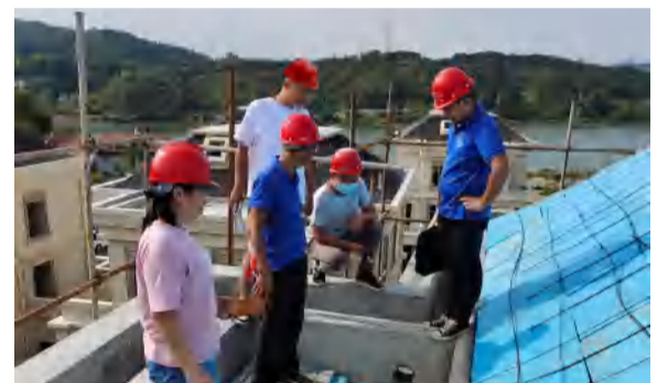
四季花海项目别墅区屋面保温板隐蔽工程验收
