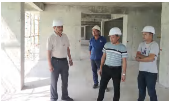
省建筑业协会专家组在中泰大公馆项目检查验收双楚杯
